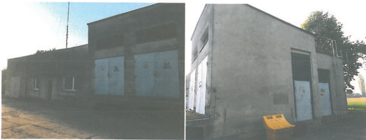
Foto nr 1 i 2 Widok elewacji północnej i zachodniej.
