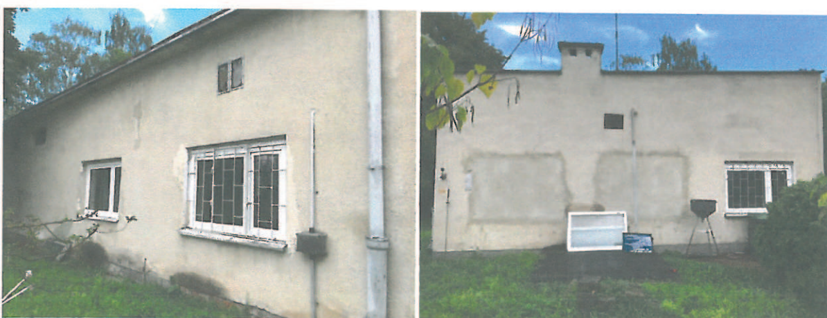
Foto nr 3 i 4 Widok elewacji południowej i wschodniej.
